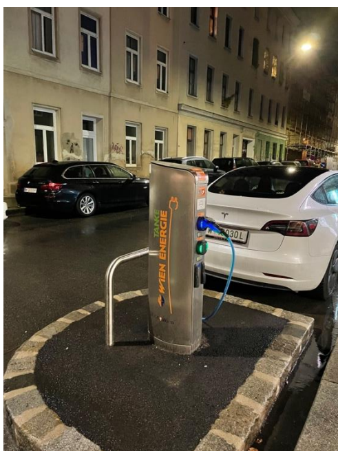
ウィーン市内で多く見られる EV 用充電ステーション。
